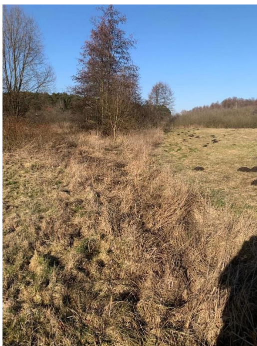
2. Niedrożny rów melioracyjny, zdjęcie zrobione podczas wizji lokalnej.
