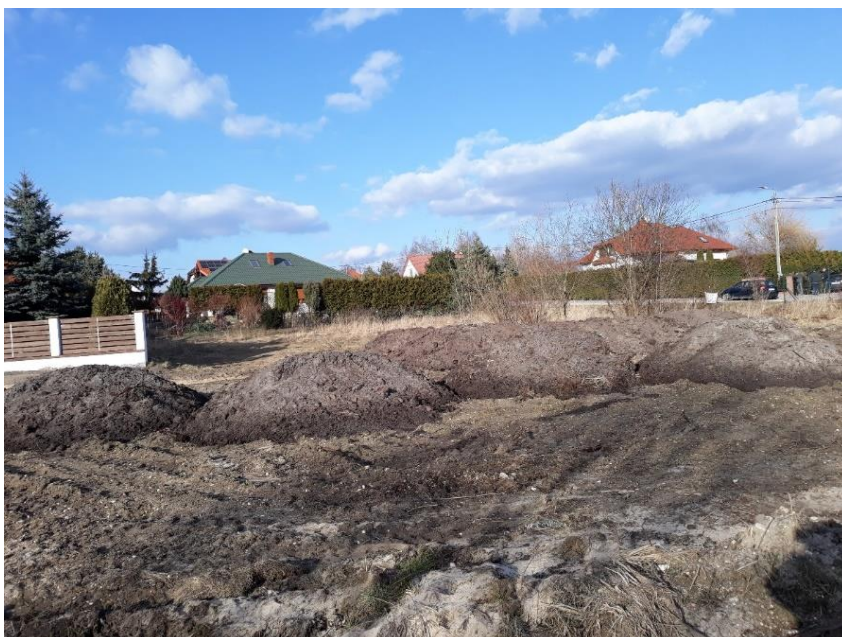
Fot. Archiwum sołectwa. Prace ziemne – 2022r.
