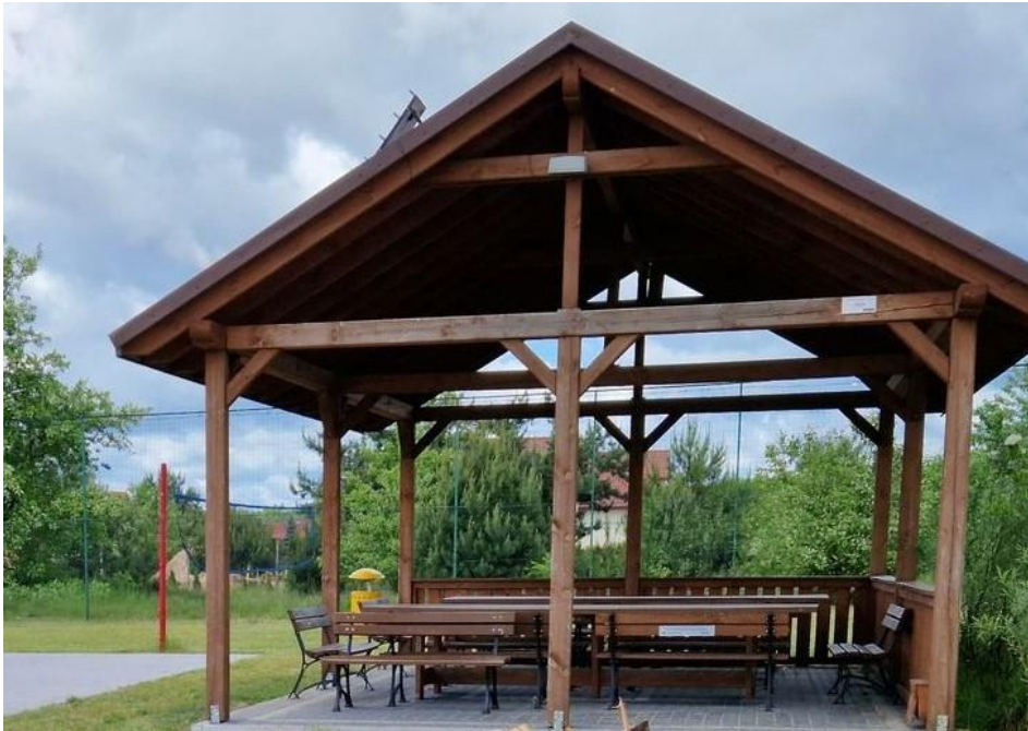
Fot. Archiwum sołectwa. Wiata przy której stanie zbiornik na deszczówkę
