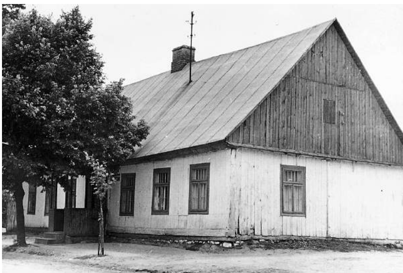
Fot. 7. Budynek szkolny wybudowany przez mieszkańców Przybyszewa w 1840 r. Służył jako szkoła do 1950 r.
