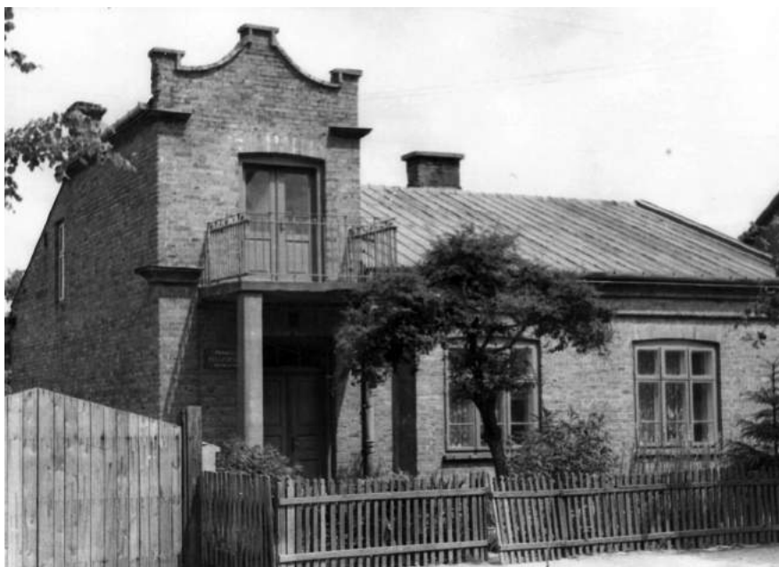
Fot. 15. Dawny punkt felczerski i położniczy w prywatnym budynku, 1962 r.
